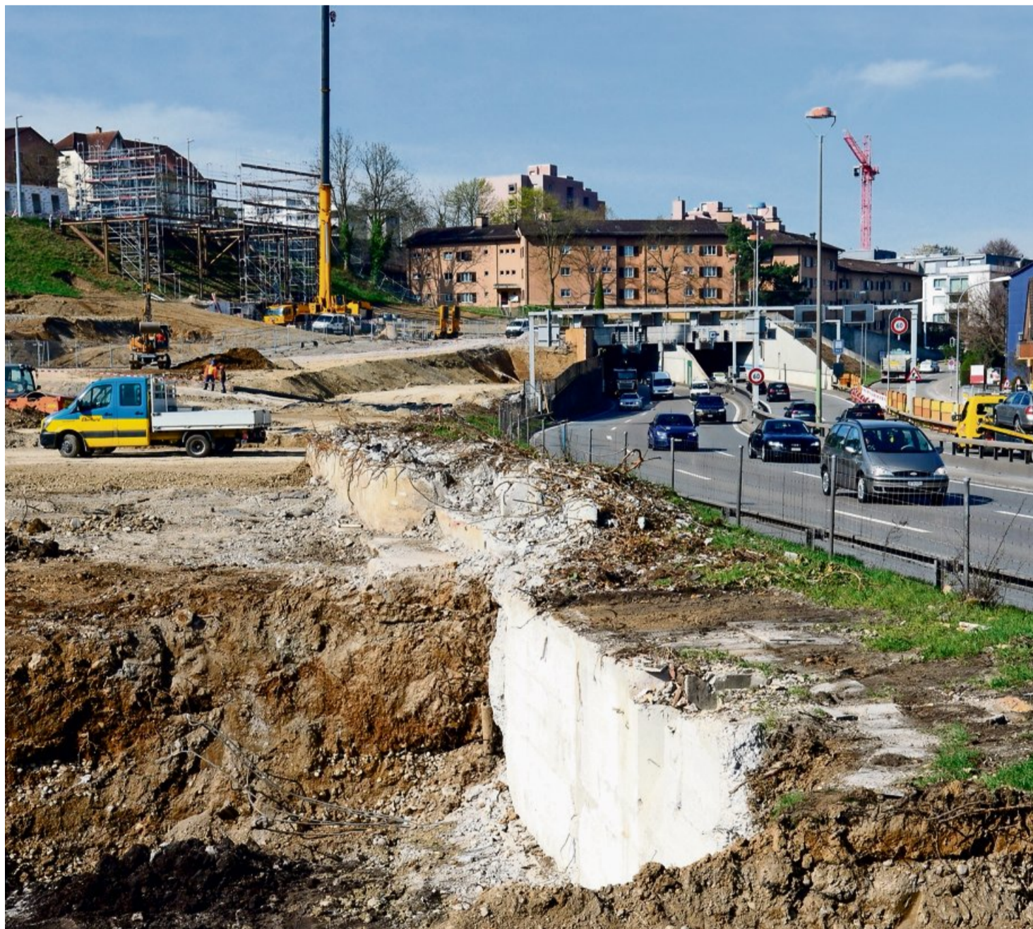
Vor dem Zürcher Schöneichtunnel sind 19 Häuser abgerissen worden. In einem Jahr geht es los mit der Einhausung Schwamendingen. Foto: Marc Dahinden
